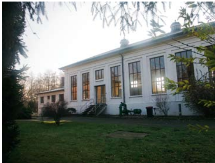
Ehemaliges Wasserwerk Wilhelmshurg
